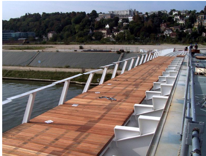
Aménagement de trottoirs sur pont
